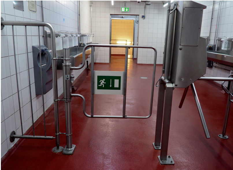
Abb. 5: Hygieneschleuse mit Fluchttür
