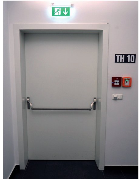
Abb. 4: Fluchttür mit Panikstange
