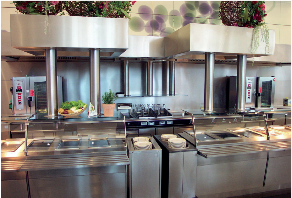
Abb. 6: Düsenplatten im Frontcooking-Bereich
