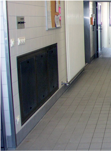
Abb. 16: Ein in die Wand integrierter flacher Quellluftdurchlass (mit Spritz- bzw. Reinigungsrand).
