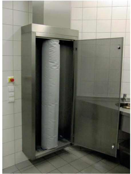
Abb. 17: Textiler Luftsack in einem wandständigen Zuluftdurchlass zur gleichmäßigen Verteilung der Zuluft über die gesamte Auslassfläche.
