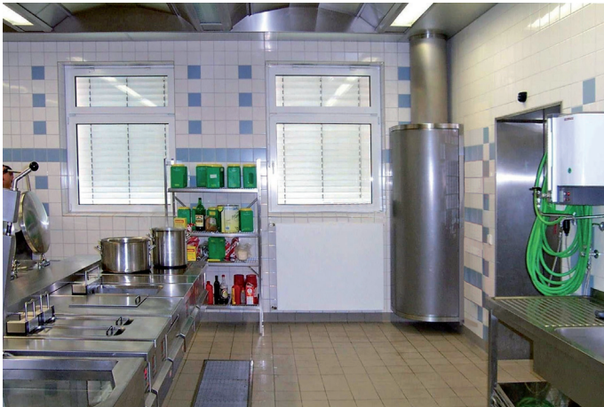
Abb. 14: Der Quellluftdurchlass (Viertelzylinder) in der Ecke hinten rechts ist über dem Fußboden positioniert. Dadurch ist eine leichte Reinigung unter dem Auslass möglich.
